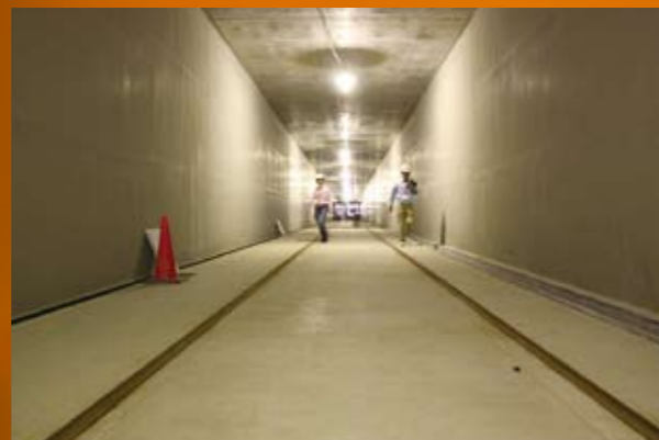
全長400mに及ぶ加速器棟のトンネル内
