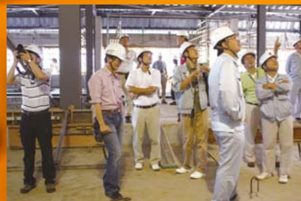
建設中の建屋細部を確認するスタッフ
