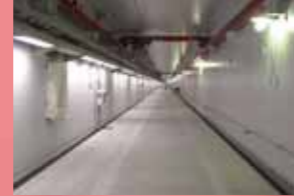
加速器トンネル
