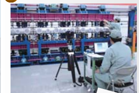
アンジュレータの据え付け作業開始
